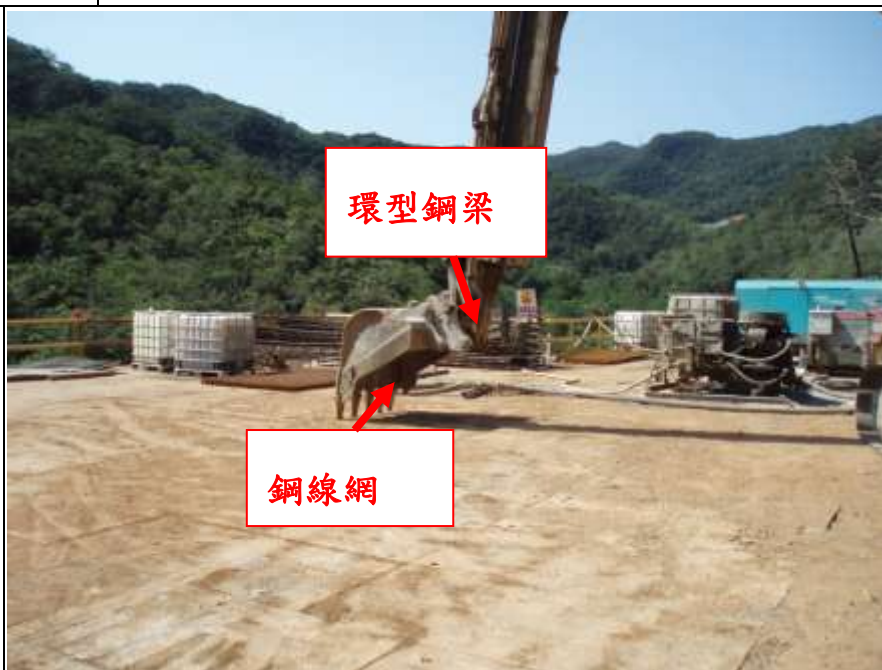
說明二 照片二：P56 橋墩基礎井基上方地面之施工構台。
