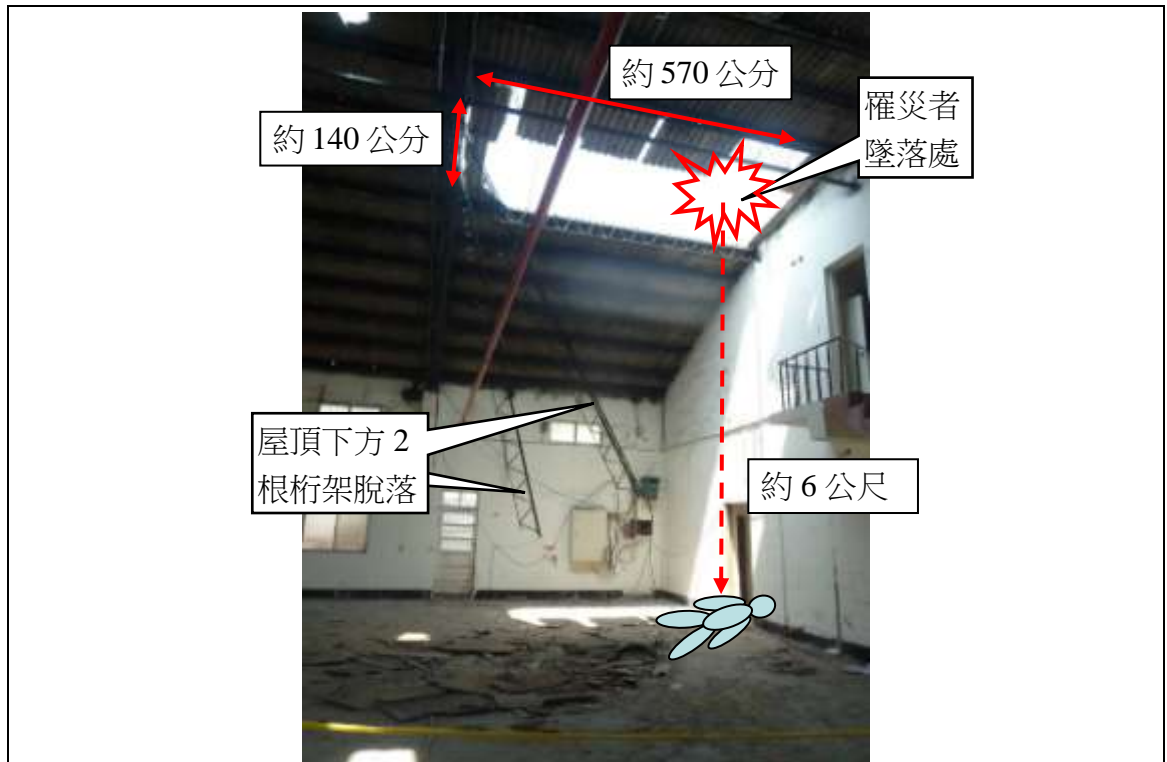
說明一 災害現場屋頂照片
