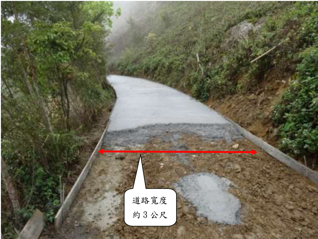
說明 照片 2：車輛迴轉處距離施工處約 25 公尺，道路寬度約 3 公尺 (工地里程 0K+410)
