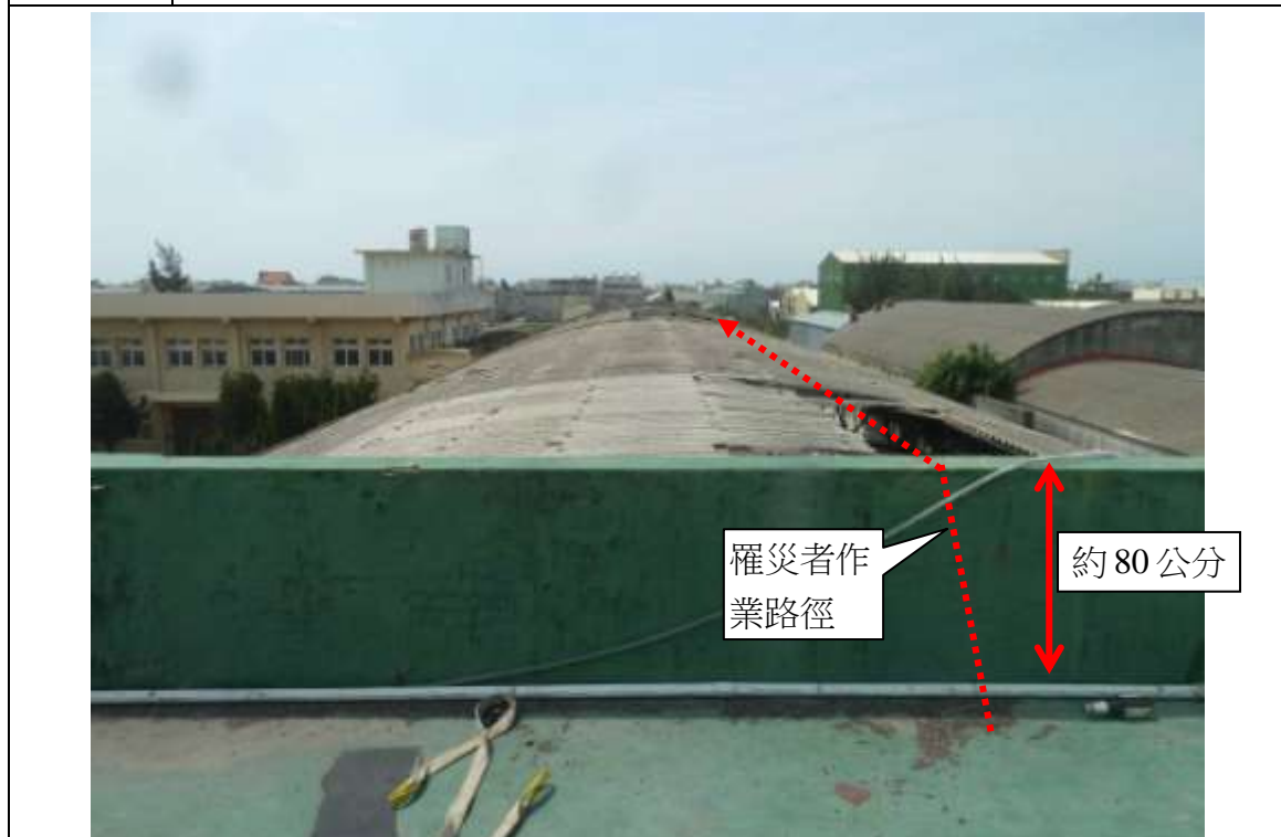
說明二 2 層樓建築物之頂樓露台及女兒牆
