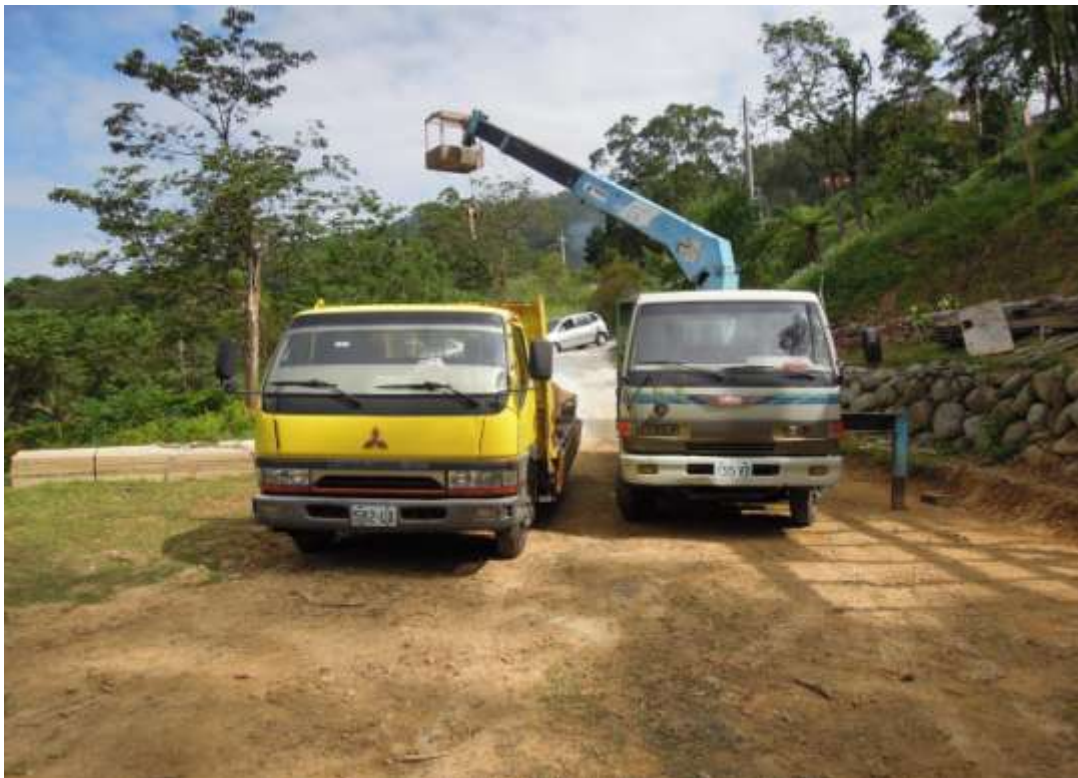
說明 2 現場照片
