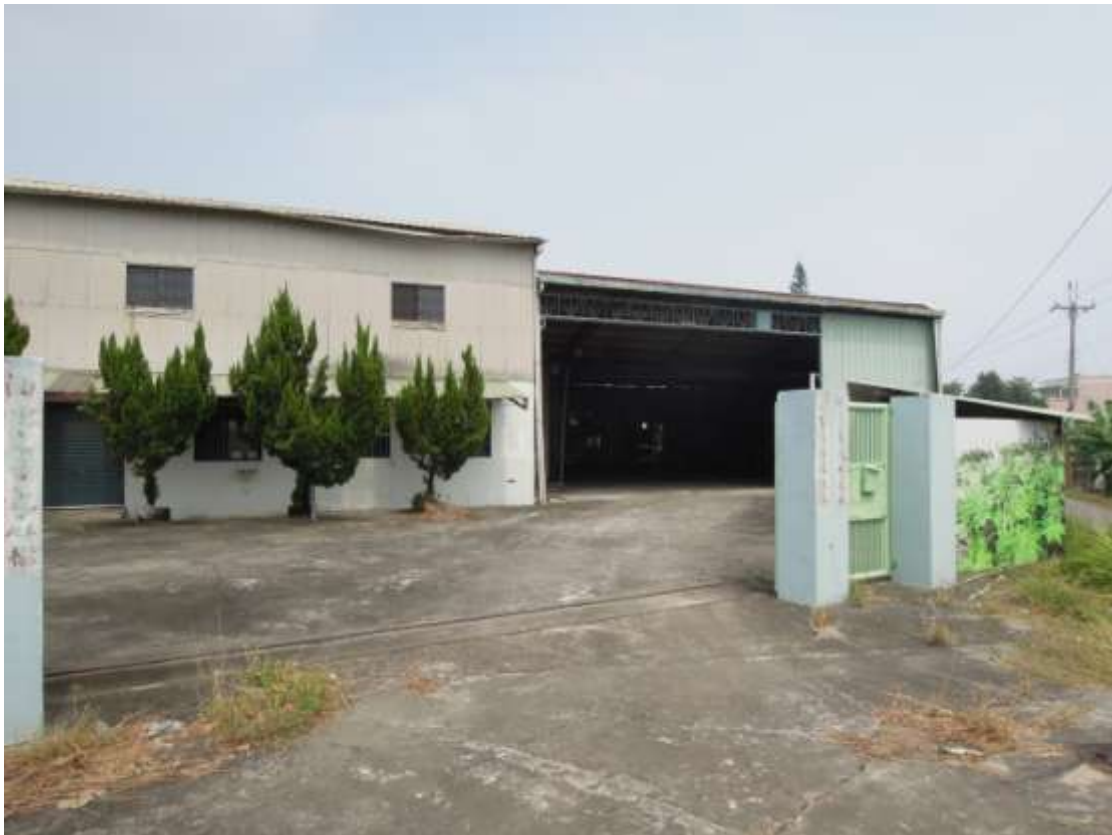
說明 1 災害現場廠房
